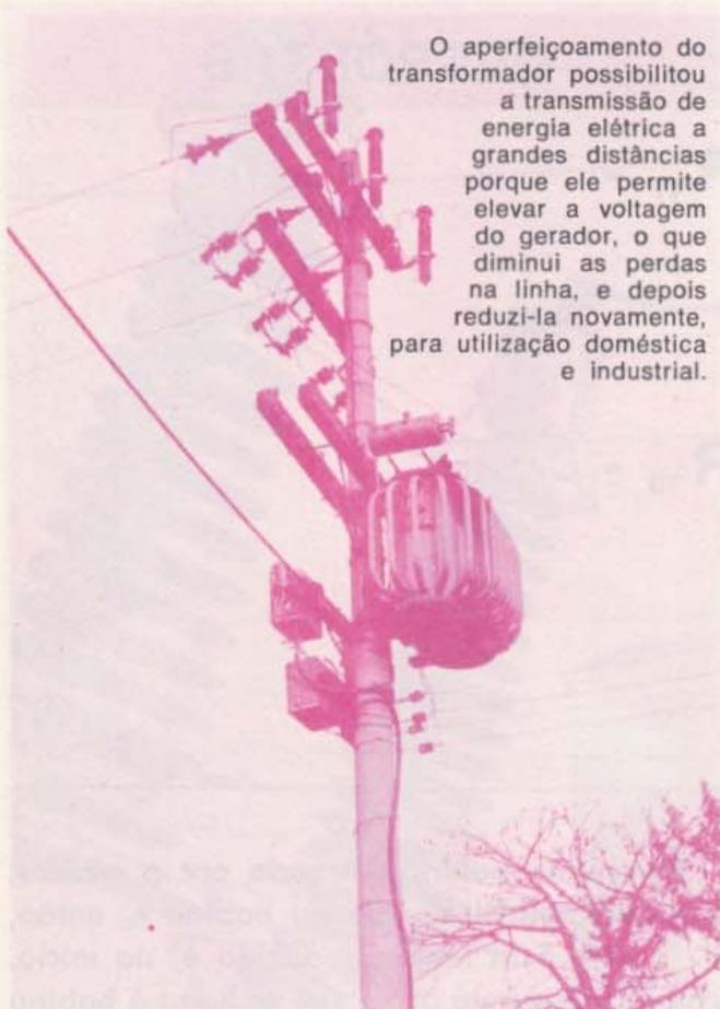
O aperfeiçoamento do transformador possibilitou a transmissão de energia elétrica a grandes distâncias porque ele permite elevar a voltagem do gerador, o que diminui as perdas na linha, e depois reduzi-la novamente, para utilização doméstica e industrial.
